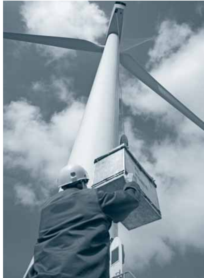
▲ Unsere Krane und Hebezeuge werden bei der Wartung von Windkraftanlagen eingesetzt.
